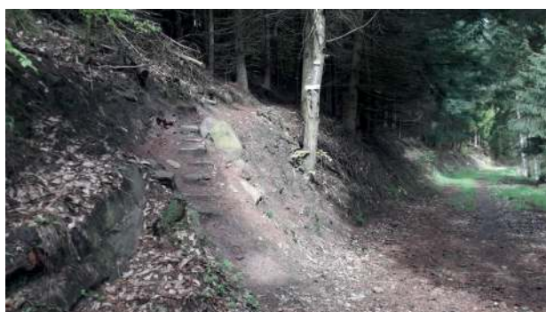
Sentier Obersteigen-Sattelsfels rouge avant travaux
