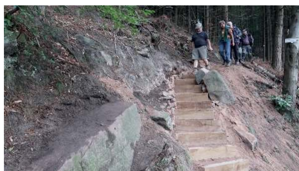
Sentier Obersteigen-Sattelsfels après travaux
