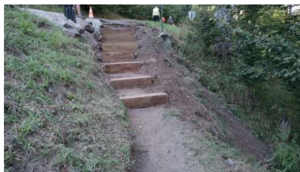
Entrée du sentier Relais Hertzien-Obersteigen après travaux
