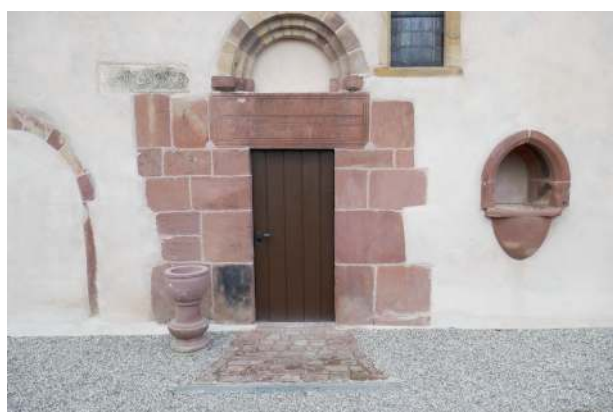
Porte d'entrée du mur sud de la nef
